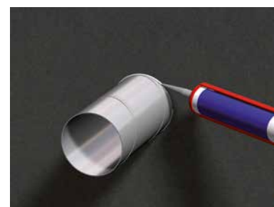
Fugning rundt om gennemføringer
