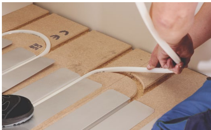
Figur 10 Montering af varmeslanger.
